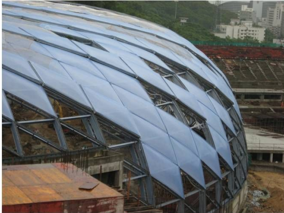
그림 8. ETFE 막재 설치 작업
