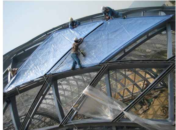
그림 9. ETFE 막재 설치 작업
