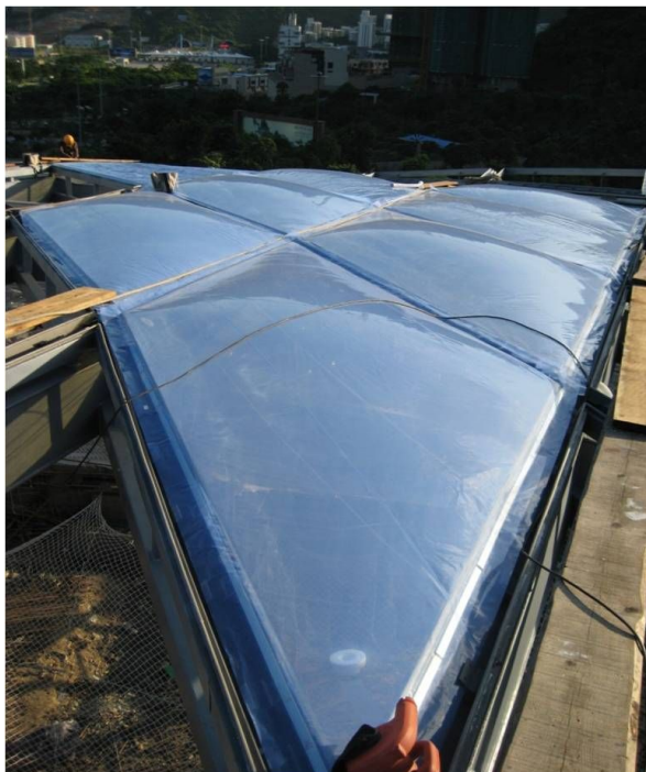
그림 10. ETFE 막구조에 임시 공기 주입
