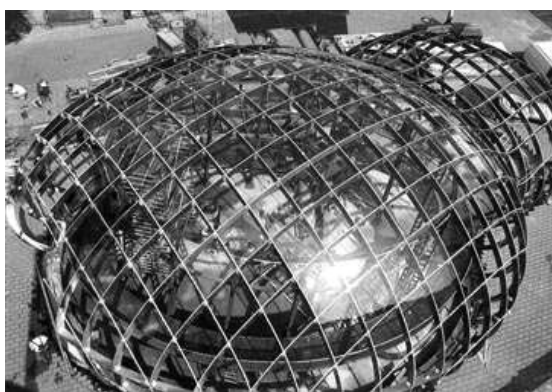
<그림 2> 투명 아크릴 판넬과 알루미늄뼈대가 설치된 모습 11)
