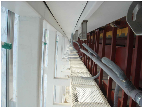
그림 17. 상부 송풍배관 (ETFE연결 전)
